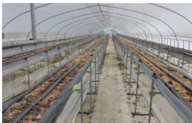
植付前の高設施設
